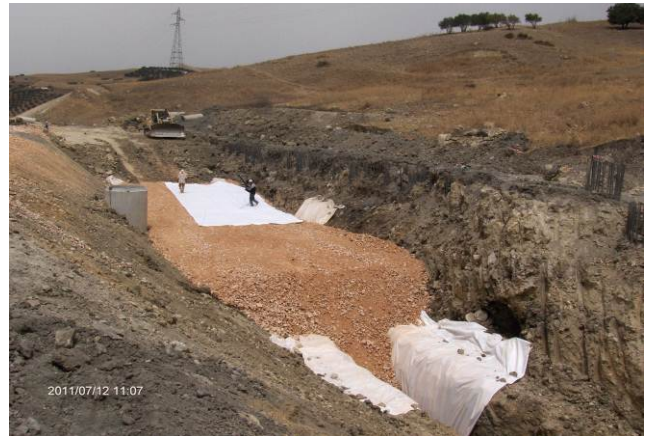
Photo4 : réalisation de la tranchée amont
