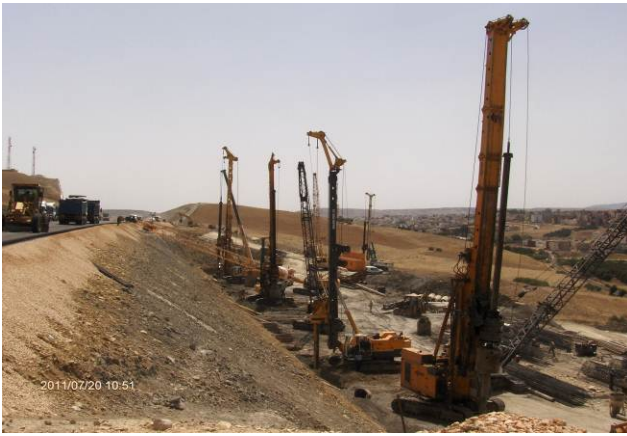
Photo3 : 4 foreuses en actions sur 180 ml
