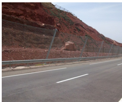
Début mai 2011 : Chute d'un gros bloc au niveau de la zone intermédiaire (non couverte par la parade) ;
