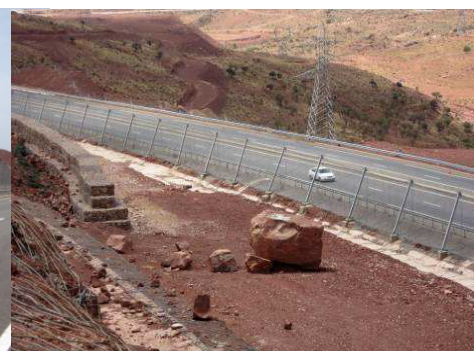
Début mai 2011 : Chute d'un gros bloc au niveau de la zone intermédiaire (non couverte par la parade) ;
