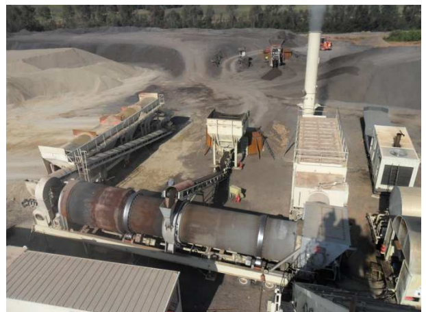
Fabrication de l'enrobé recyclé (poste TSM équipé d'un anneau de recyclage)
