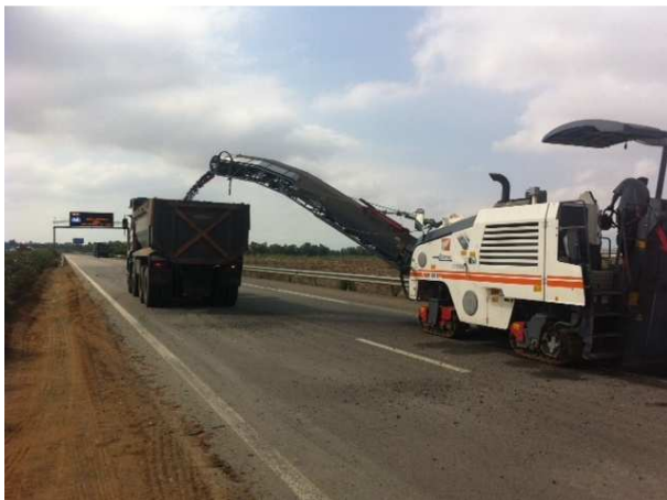
Opération de rabotage de la voie lente avec récupération des fraisâts
