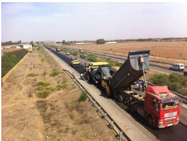
Travaux de mise en œuvre de l'enrobé recyclé
