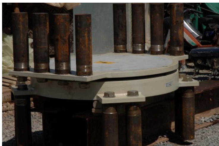
Installation des réservations et appui fixe sur palme centrale
