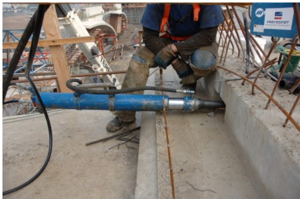
Vues des opérations de tension des câbles transversaux
