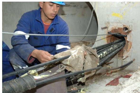
Vues des opérations de précontrainte extérieure
