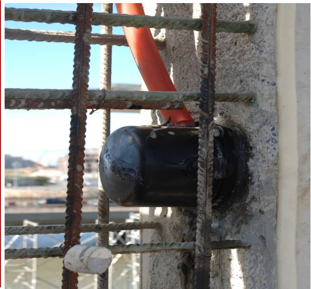
Fixation du câble de terre et protection par capot plastic
