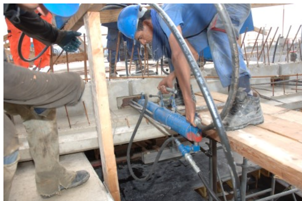
Vues des opérations de tension des câbles transversaux
