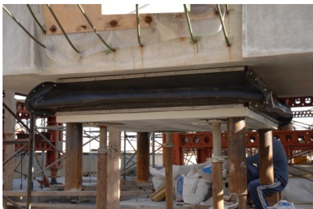
Installation de l'appui sous le pied de palme et vue des événements d'injection
