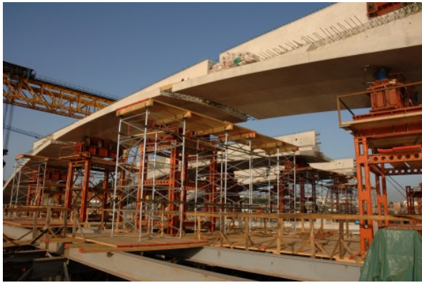
Pose des poutres longitudinale et ferrailage des béquilles
