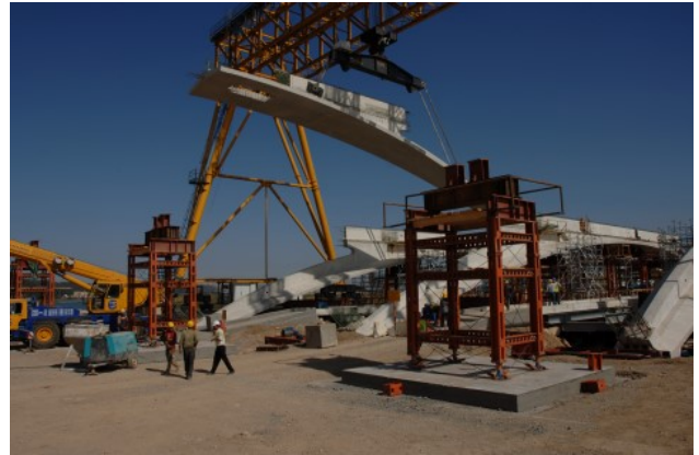
Vues du système de support des palmes en phase provisoire
