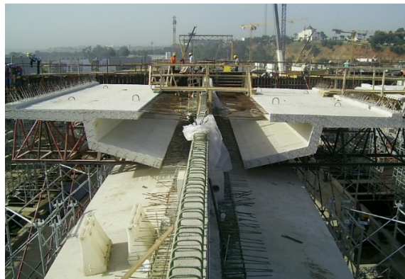
Vues des coffrages et éléments préfabriqués
