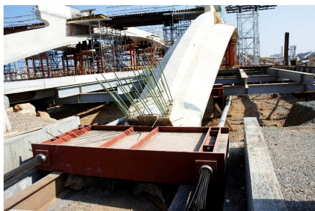
Tirants en place ajustement des tensions des torons
