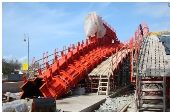
Vues des coffrages et éléments préfabriqués
