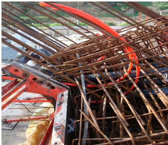
Installation des réservations et appui fixe sur palme centrale
