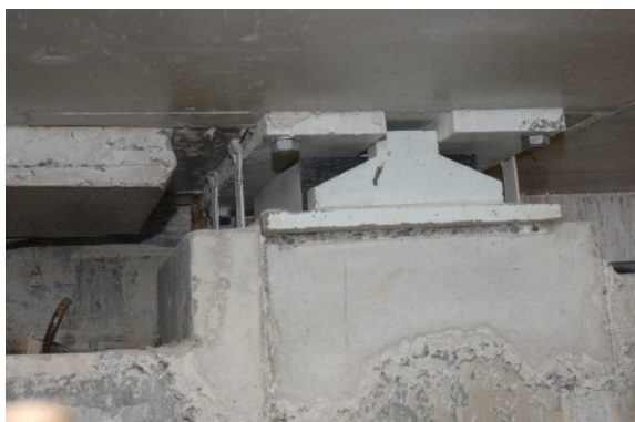
Vues des appuis en néoprène avec système de butée
