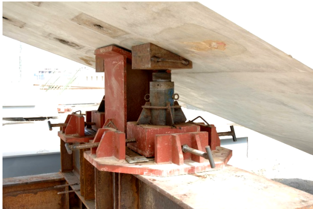
Vues du système de support des palmes en phase provisoire
