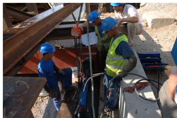
Tirants en place ajustement des tensions des torons
