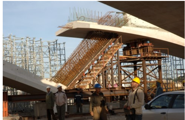
Pose des poutres longitudinale et ferrailage des béquilles
