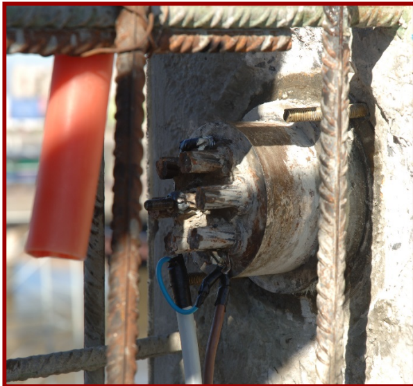
Fixation du câble de terre et protection par capot plastic
