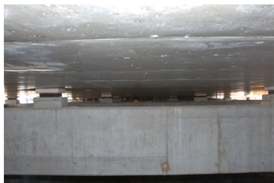
Vues des appuis en néoprène avec système de butée
