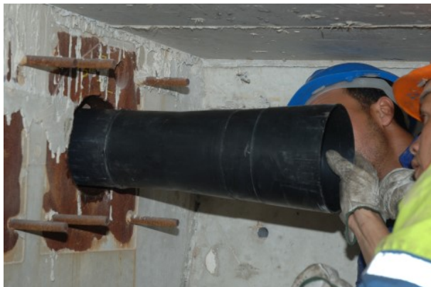
Vues des opérations de précontrainte extérieure
