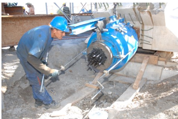
Vues des différentes opérations de précontrainte intérieure
