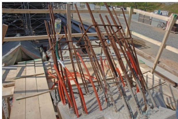
Installation de l'appui sous le pied de palme et vue des événements d'injection
