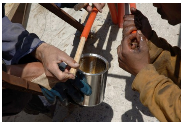
Injection de la résine époxy
