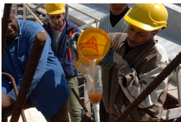
Injection de la résine époxy
