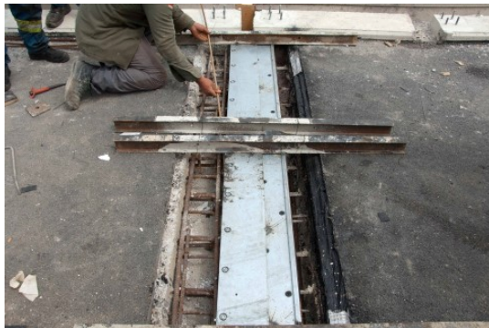
Vues des opérations de pose des différents joints de chaussée
