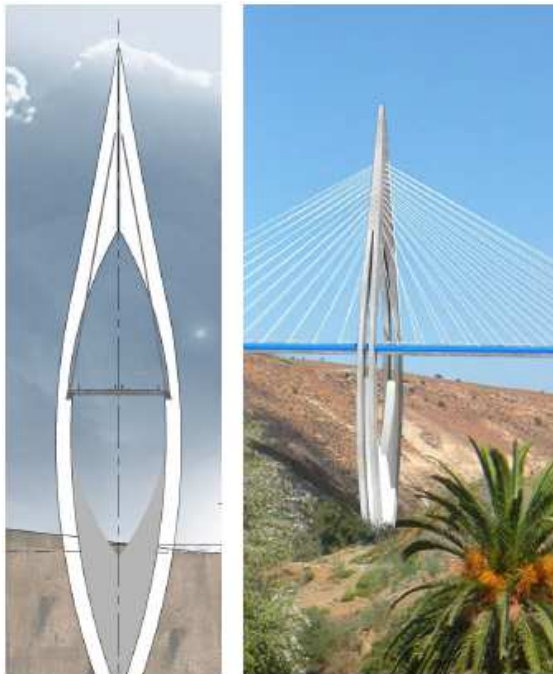
Figure 18 : pylône à nappes latérales
