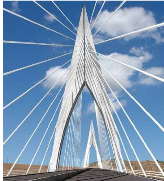
Figure 16 : vision de passage entre les jambes du pylône
