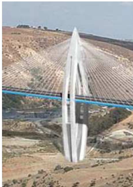
Figure 23 : vue du pylône
