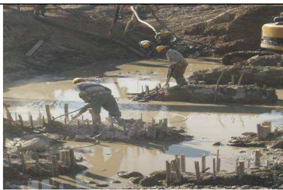
Figure 20 - recépage des têtes de barrettes
