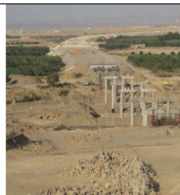
Figure 23 - Exécution du coffrage et ferrailage des chevêtres des piles
