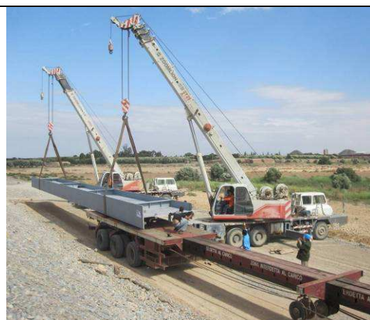
Figure 33- Chargement des poutres sur des camions télescopiques
