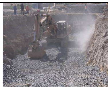
Figure 8 - Mise en œuvre du matelas drainant
