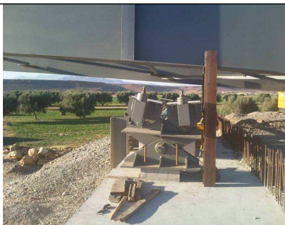
Figure 40 - balancelle équipée de rouleaux pour guidage latéral
