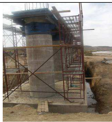
Figure 21- Exécution du ferrailage des chevêtres et fûts des piles
