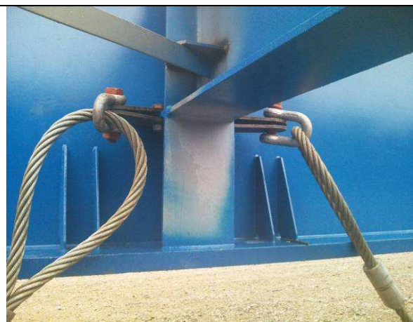
Figure 50 - Accrochage des élingues sur les poutres
