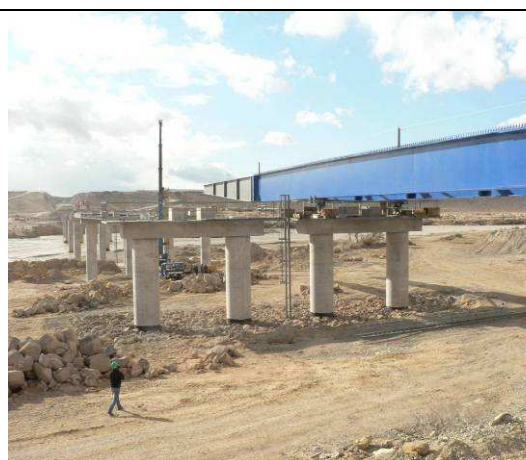
Figure 62 - Première travée lancée
