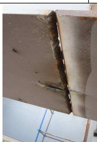
Figure 37 - Montage et assemblage des poutres sur site
