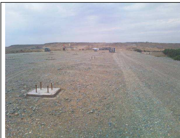
Figure 35 - Plate forme d'assemblage sur site
