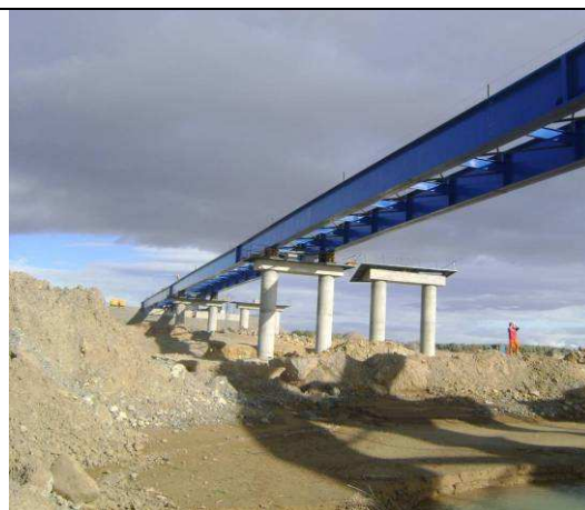
Figure 62 - Première travée lancée
