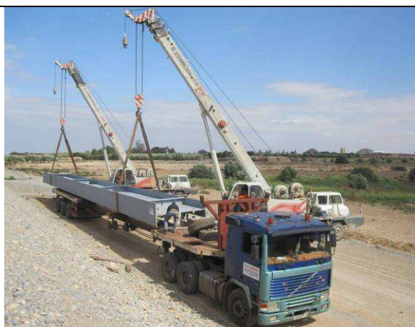
Figure 34 - Arrivée des poutres sur site et déchargement
