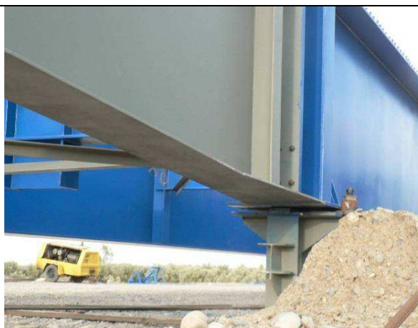
Figure 39 - Avant-bec – Jonction avec poutres
