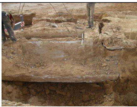
Figure 19 - Démolition des murettes guide
