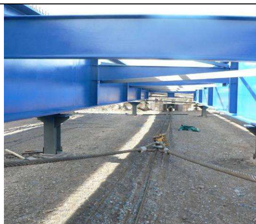
Figure 51 - 5- Elingues de lancement et moufle ancrée au fond sur culée C8.
