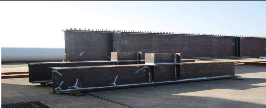
Figure 32 - Poutres prêtes à l'expédition sur site
