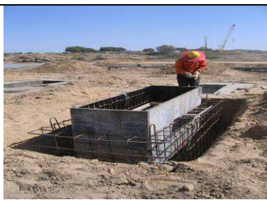
Figure 10 - exécution du coffrage et ferrailage des murettes guide
