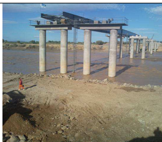
Figure 63- arrivée du tablier sur la pile P2
