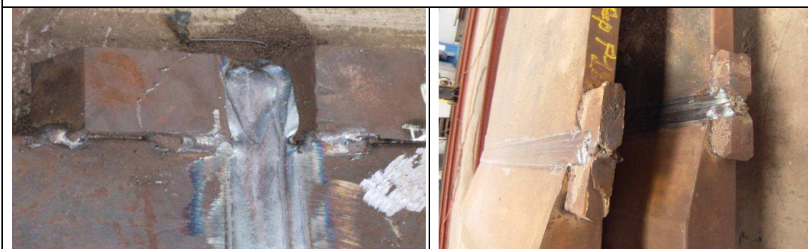
Montage et assemblage en usine
