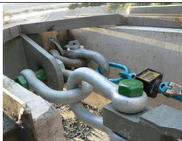
Figure 48 - Ancrage de la moufle de tirage et du balan sur C8
