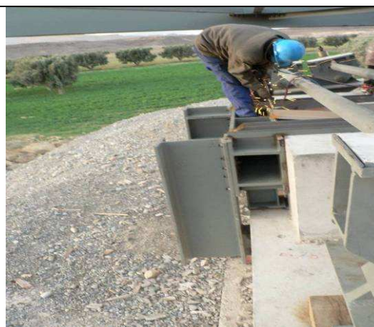
Figure 47 - Chevêtre d'ancrage sur culée C8 de la moufle de tirage
