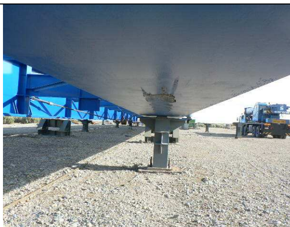
Figure 54 – traces de savon noir en dessous des semelles inférieures pour réduire les frottements
