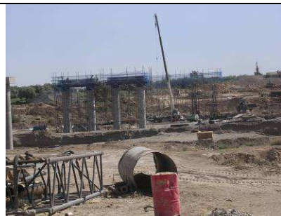
Figure 21- Exécution du ferrailage des chevêtres et fûts des piles
