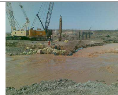
Figure 16 - Confortement de la plate forme de forage après une crue
