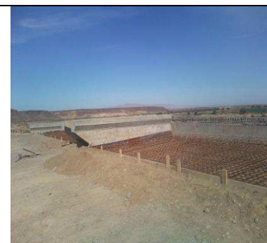
Figure 24- Exécution du coffrage et ferrailage de la dalle de transition
