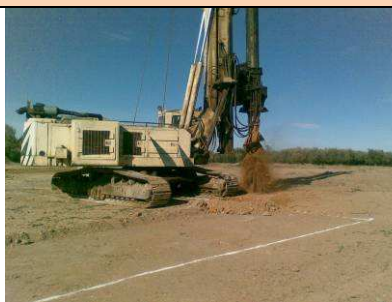
Figure 5 - Exécution des préforages
