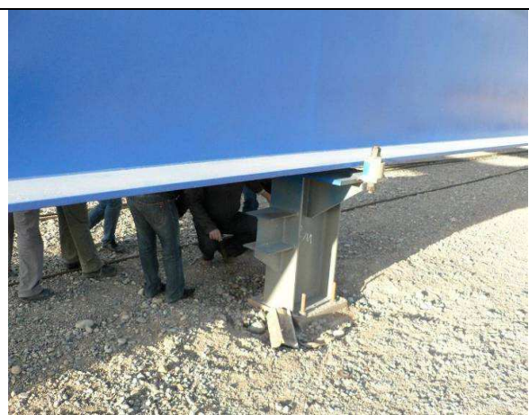
Figure 52- Plot d'appui sur l'aire de montage avec ergot de vérinage
