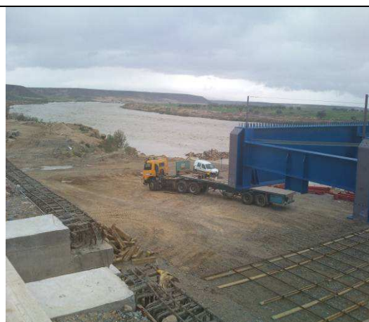
Figure 65 - Le tablier à 8 m de l'arrivée sur C0
