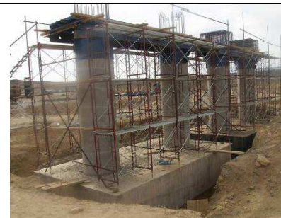
Figure 23 - Exécution du coffrage et ferrailage des chevêtres des piles
