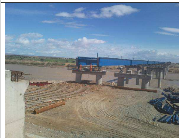
Figure 64 - arrivée du tablier sur la pile P1
