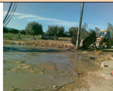
Figure 6 - Déversement du ballast
