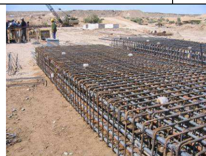
Figure 14 - Préparation des cages d'armatures
