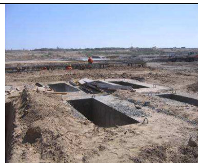
Figure 11 - Bétonnage des murettes guide
