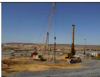
Figure 5 - Exécution des préforages
