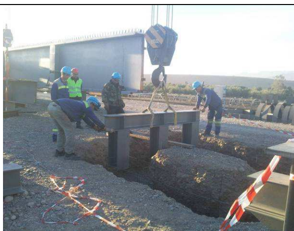
Figure 44 - Massif d'ancrage pour le treuil de traction et le treuil de retenue
