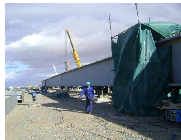
Figure 36 - Abris de soudage sur site
