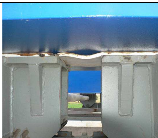
Figure 58 – déplacement du PTFE de la balancelle C8 en cours de lancement
