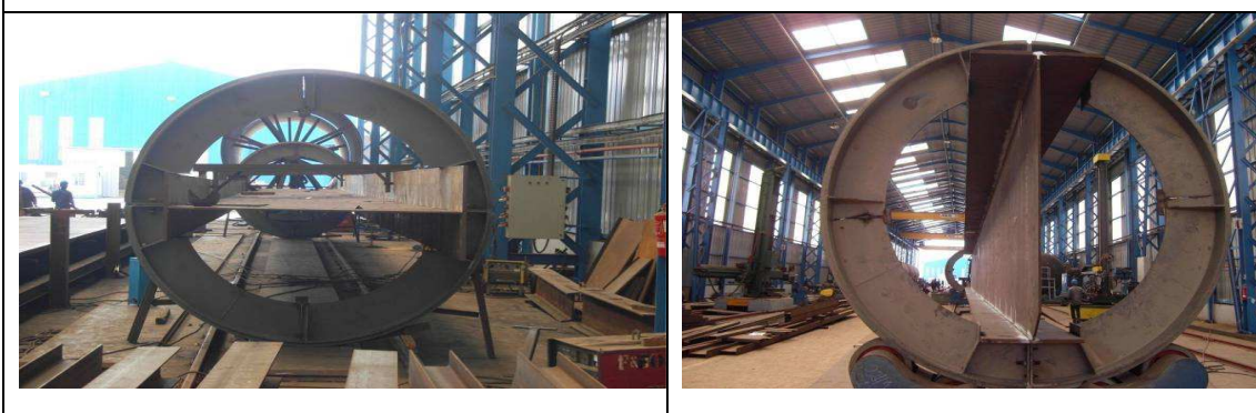
Figure 30 - Montage et assemblage en usine
