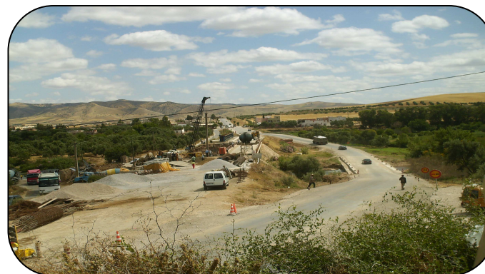
Création d'un radier évidé à Amont de O.A
