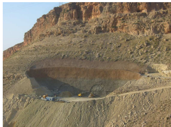
Photo 10 : Mise en place soutènement au niveau de la tête Sud du tunnel
