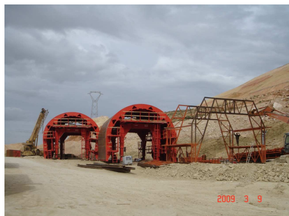
Photo 17 : Coffrage outils utilisé pour le revêtement du tunnel
