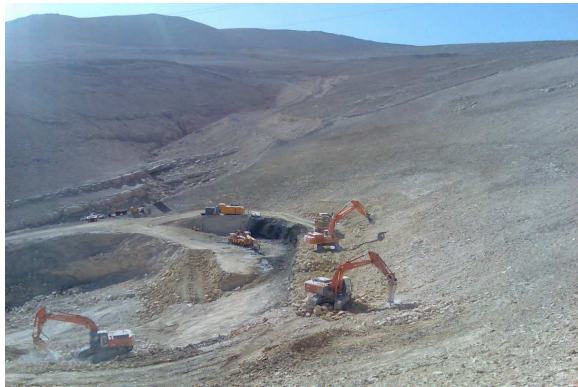
Photo 8 : Terrassement au niveau de la tête Nord du tunnel
