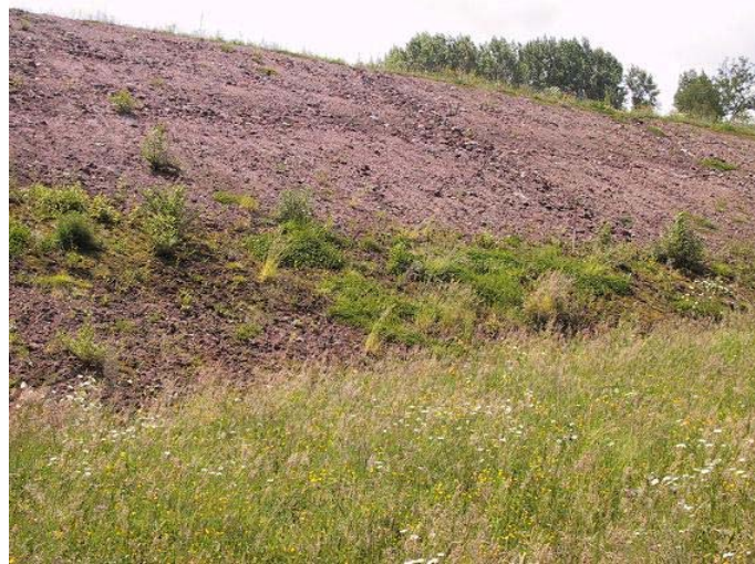
Figure 9 : zone humide en base du remblai (15 mai 2003)
