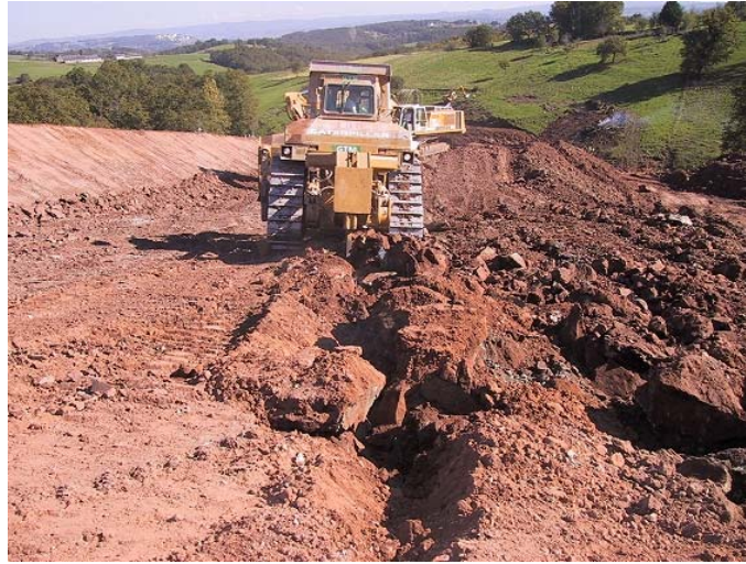
Figure 5 : extraction des pérites indurées par rippage
