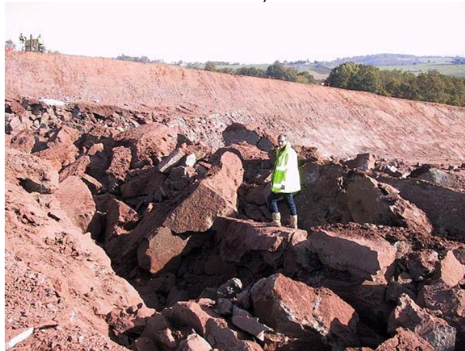
Figure 6 : extraction des pérites par minage
