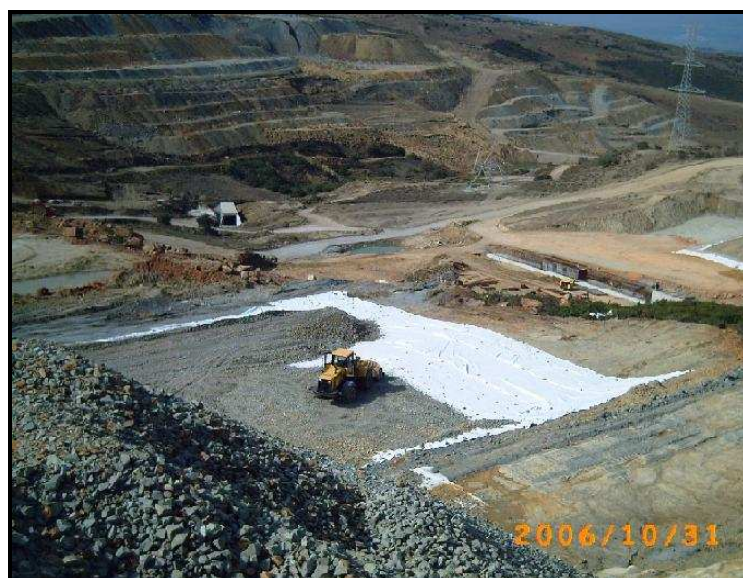
Mise en place des matériaux drainant pour bêche d'ancrage
