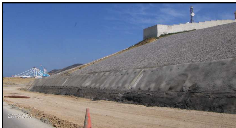
Déblai traité par clouage et béton projeté
