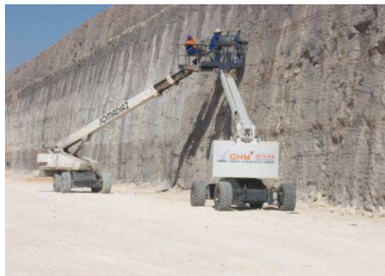
Mise en place d'un mur cloué
