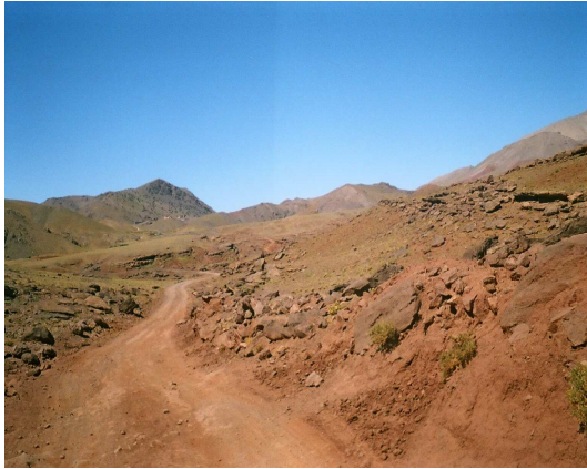
RP 1510 avant travaux
