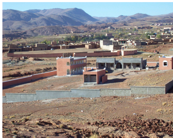
Collège en cours de construction, CR Tidili
