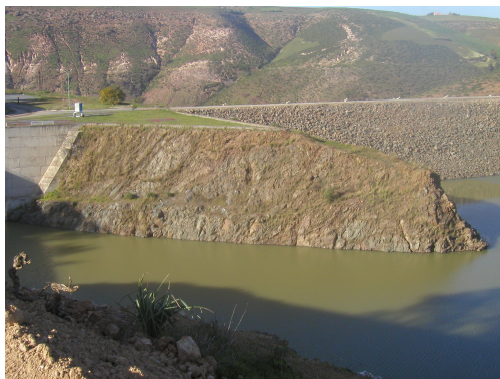
photo1 : site initial à sec
