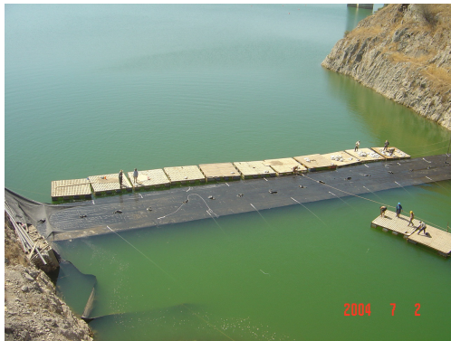
photo2 : radeau- pose géotube géotubes
