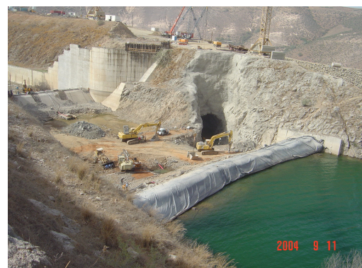
photo2 : Batardeau achevé et chantier
