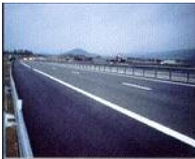
Application PR PLAST S sur voie lente autoroute
