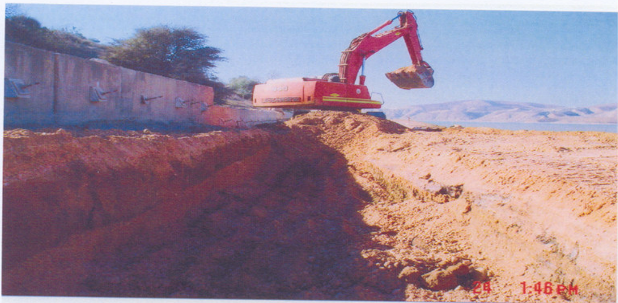
Travaux de décaissement en cours côté mûr de soutènement et parement en B.A ( En alternance)
