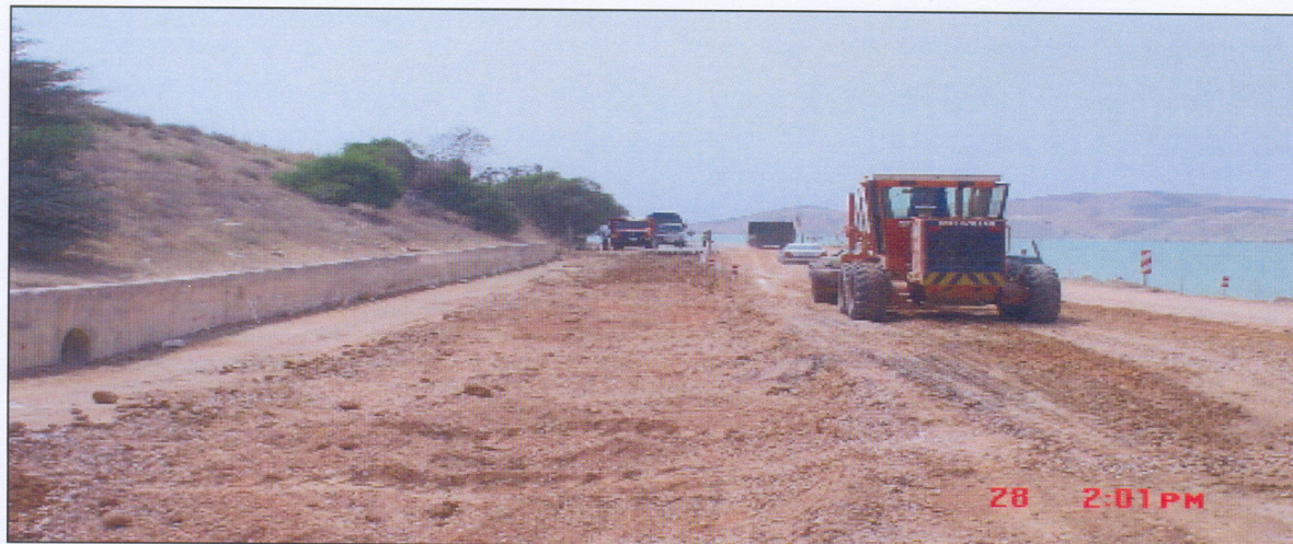
Reprofilage de la chaussée existante et aménagement de la première déviation et plateforme de travaux de foration côté mûr ONCF
