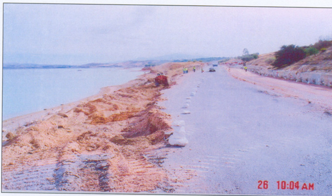
Travaux déblais en cours côté Lac
