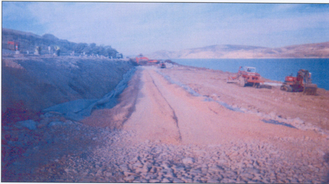
Mise en place du géotextile sur les enrochements 150/250 destiné à recevoir les matériaux 20/40
