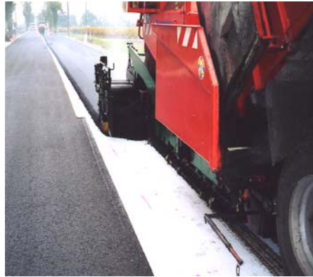
Recouvrement de 5 cm d'enrobé avec Rotaflex 833. 2006 : pas de fissures
