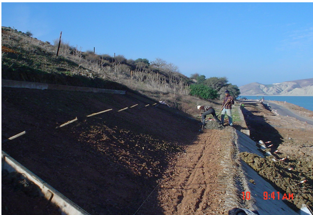
Préparation du mur de soutènement à deux nappes de tirants d'ancrage
