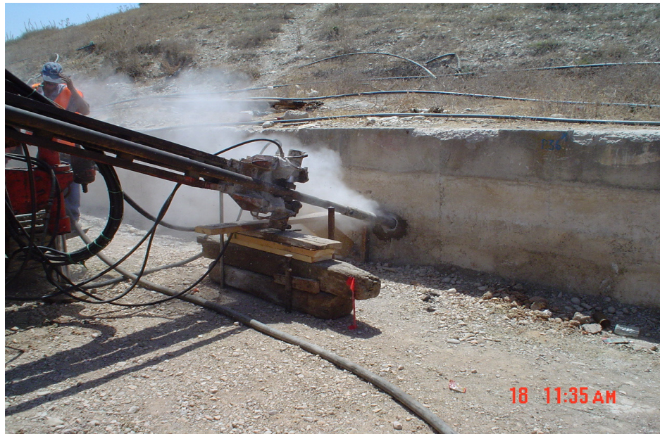
Préparation du local des tirants d'encrage
