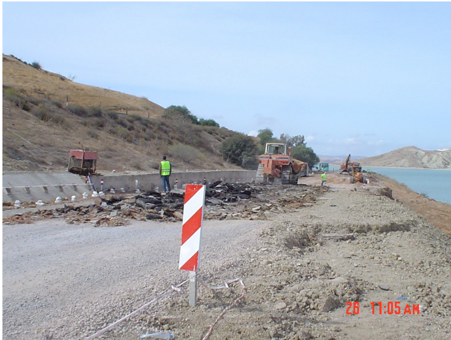
Démontage du corps de chaussée existant
