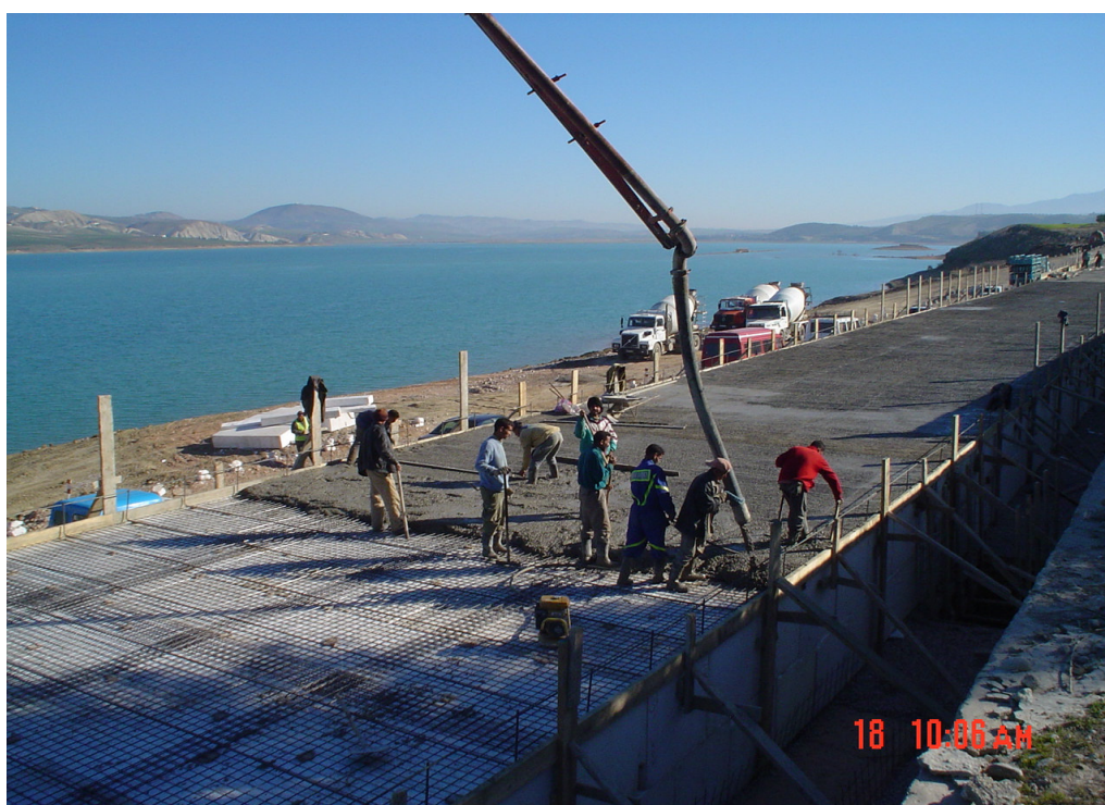
Protection du « COMPOSTYRENE » d'une dalle en béton armé
