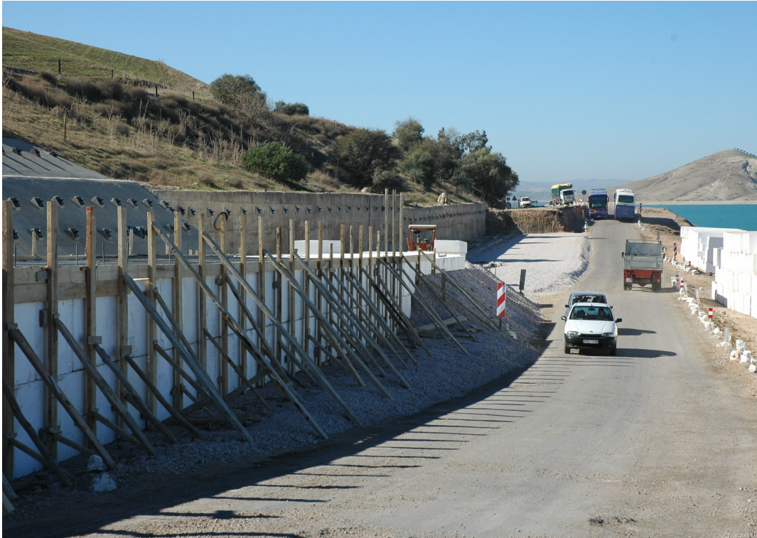
Vue de la déviation et d'une partie du « COMPOSTYRENE » mis en place
