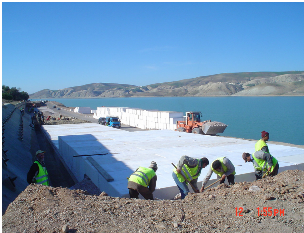
Mise en place des blocs de «COMPOSTYRENE »
