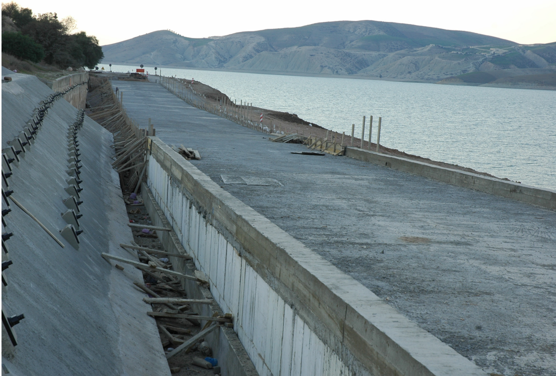
Vue générale de la section on voit notamment
