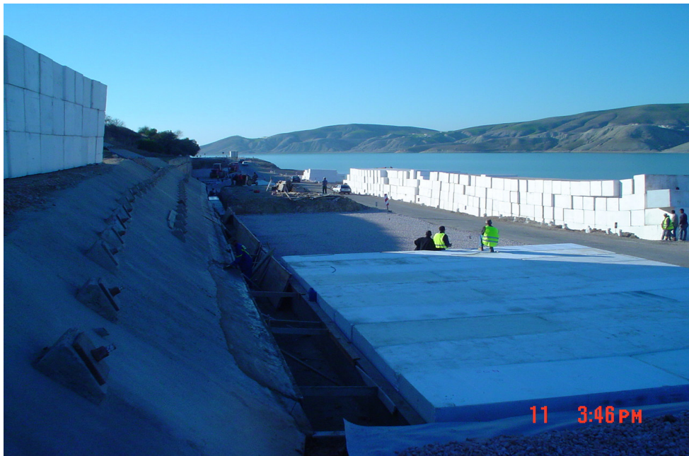
Mise en place des blocs de »COMPOSTYRENE »
