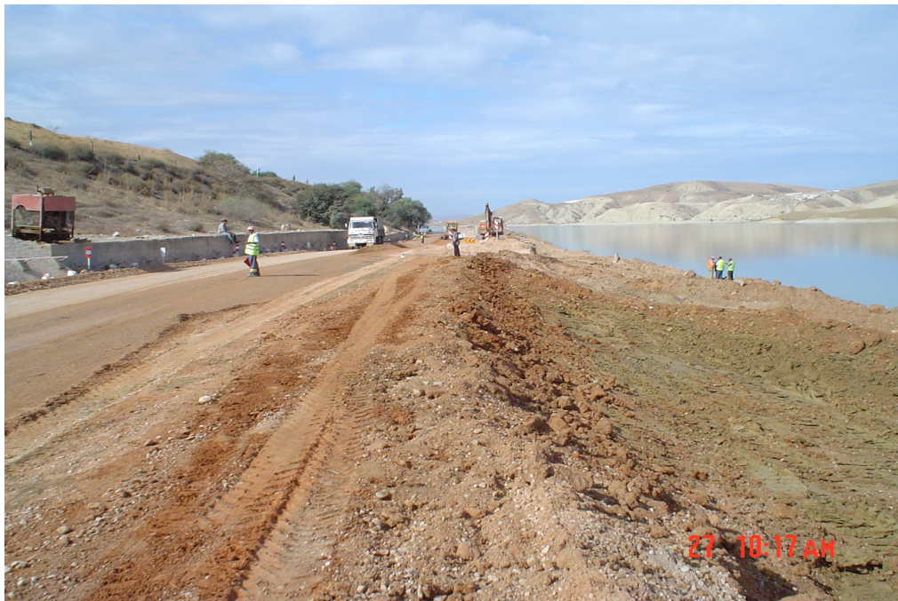
Préparation du fond de forme
