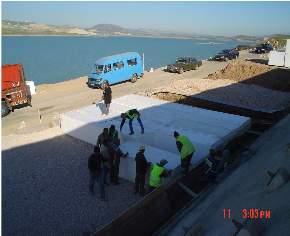
Mise en place des blocs de »COMPOSTYRENE »
