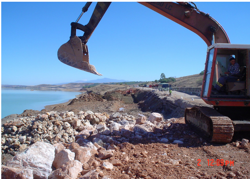
Mise en place des enrochements au niveau de la partie avale du projet
