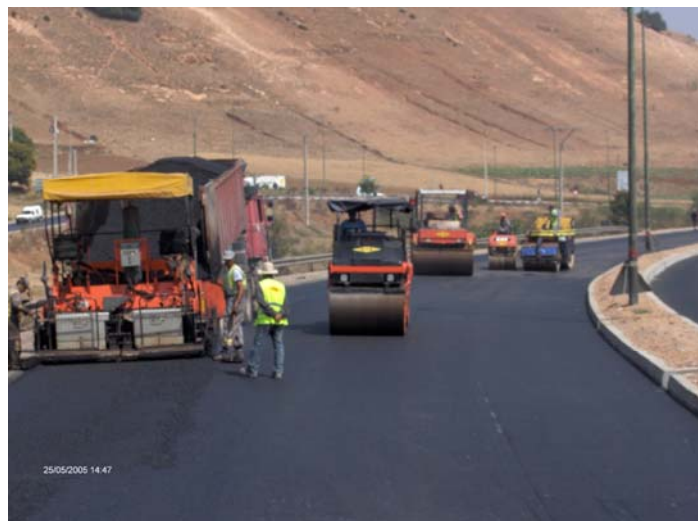
Mise en œuvre du BBME
