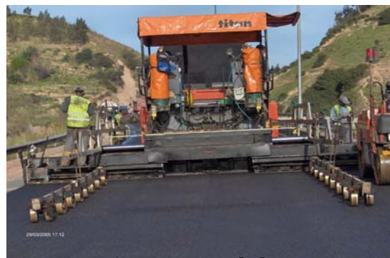
Mise en œuvre de l'EME
