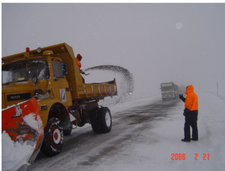
(photo n° 7) : lutte contre le verglas par l'épandage manuel du pouzzolane
