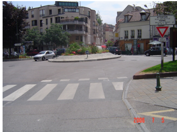
Signalisation d'un giratoire
