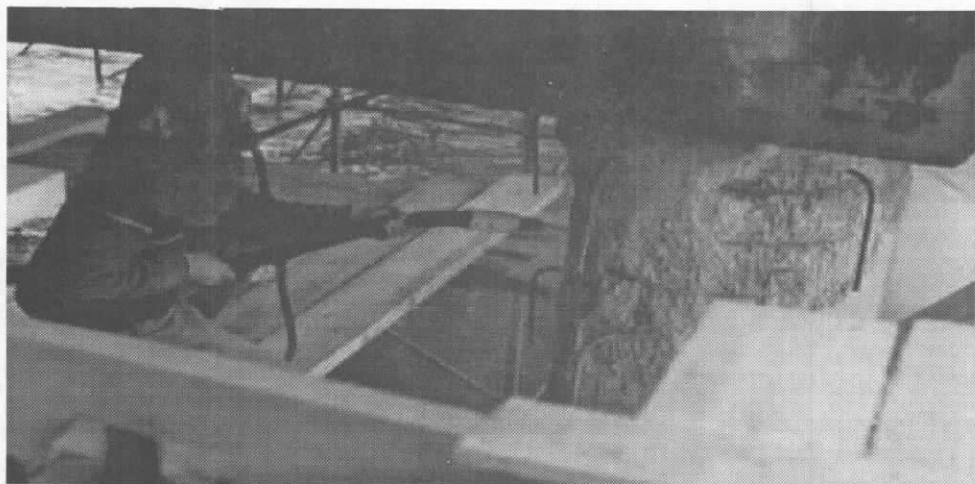
Scellement des aciers et préparation des surfaces des fûts par décapage et sablage
