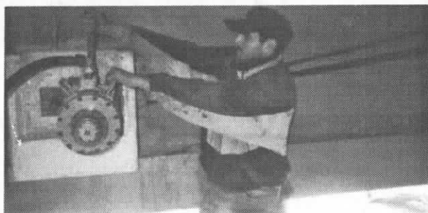
Mise en tension des barres de précontrainte
