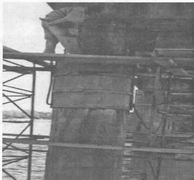
Coffrage et bétonnage de chemisage du fût
