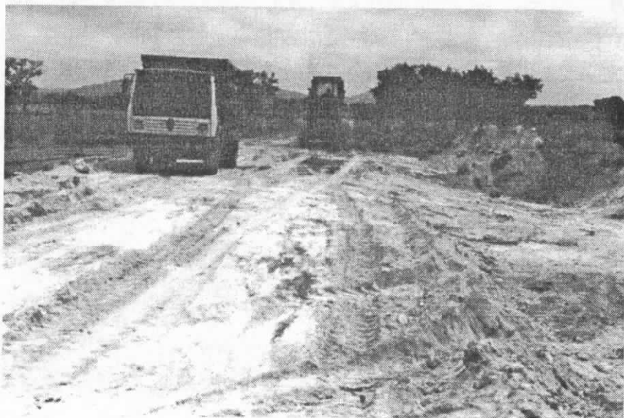
Travaux de terrassement en cours
