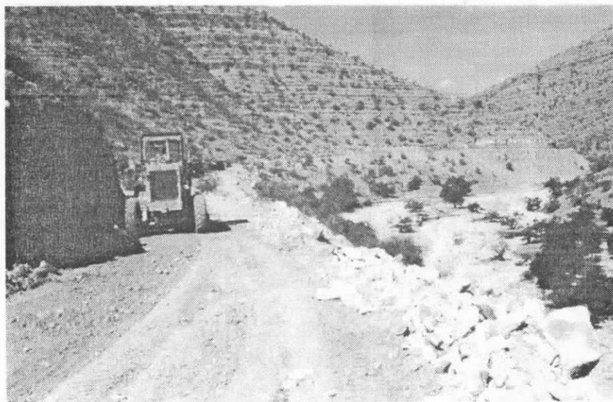
Travaux de terrassement
