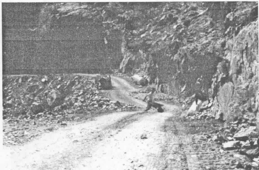
Travaux de terrassement en cours
