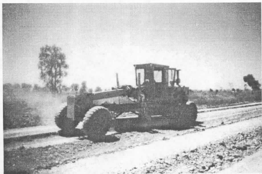
Construction de la liaison Assaki - Azaghar N'irs par le CT 7037 sur 46 kms
