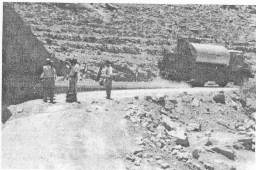
Travaux de revêtement de chaussée en cours
