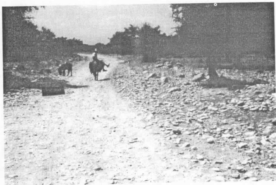
État de la liaison avant les travaux
