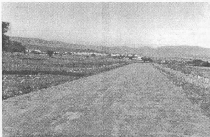
Travaux de terrassement et plate forme terminés
