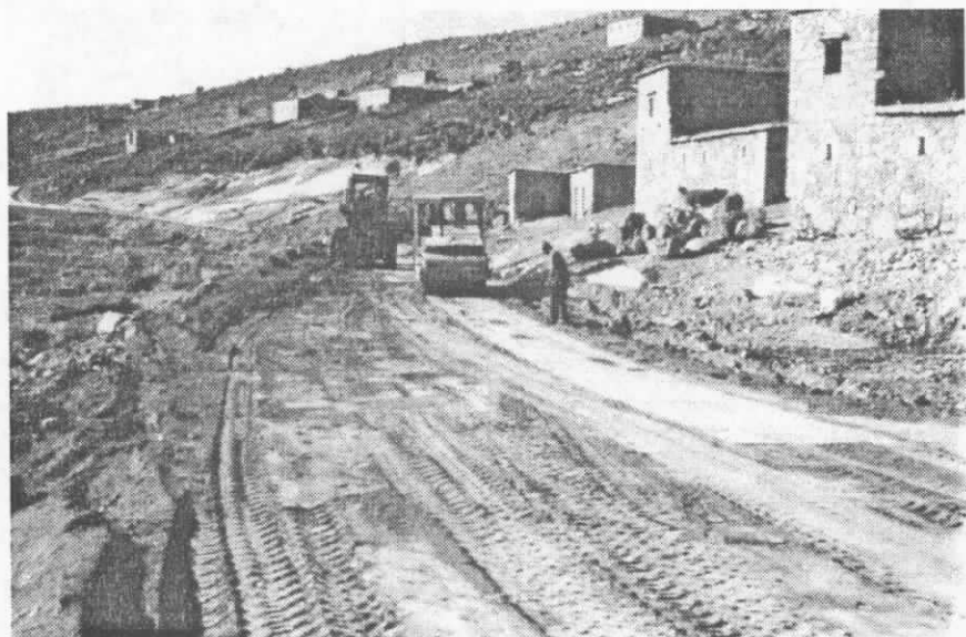
Construction de la liaison Taliouine - Askaoune par le CT 6836, Tavaux de terrassement
