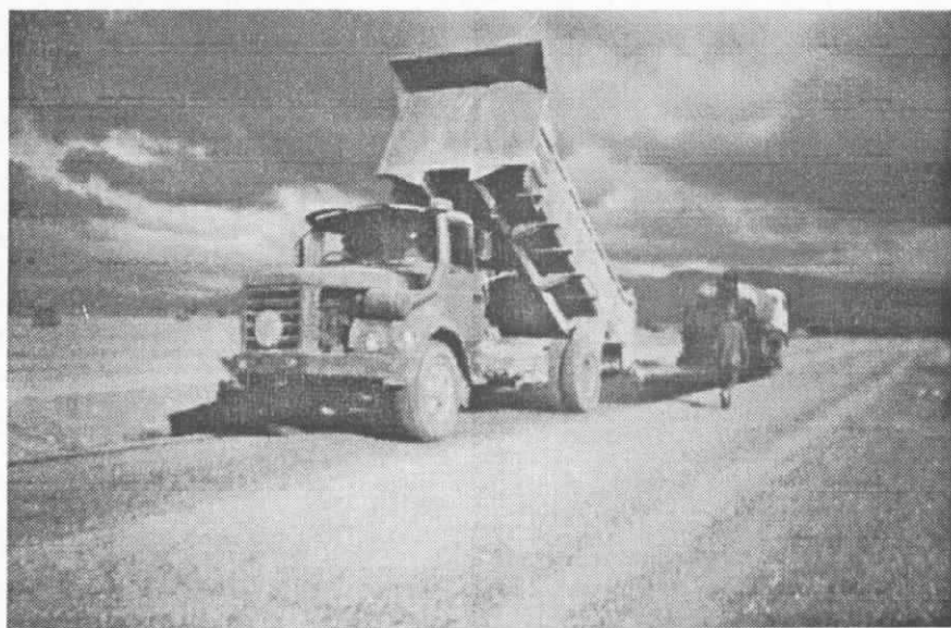
Revêtement, phase d'achèvement de travaux
