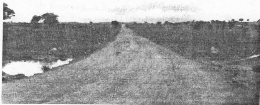
Travaux de terrassement et plate forme terminés
