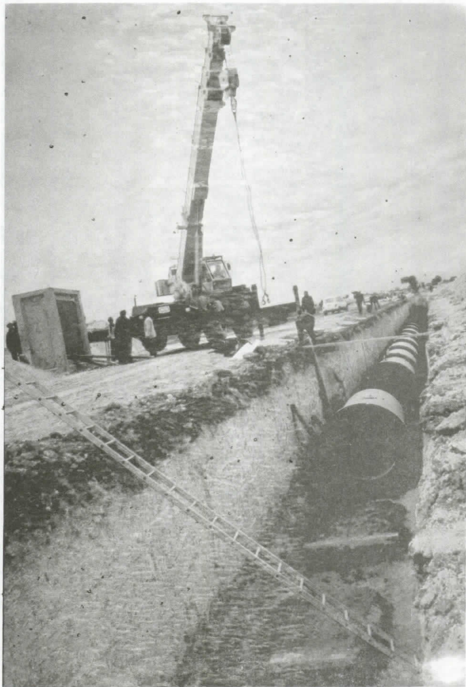
VUE DE LA MISE EN PLACE D'UN RESEAU DE DRAINAGE DES EAUX PLUVIALES
