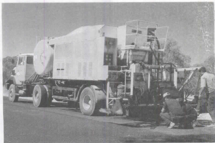
Préparation du Spreader pour la mise en oeuvre.
