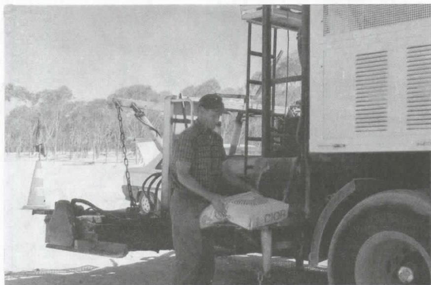
Chargement du ciment.
