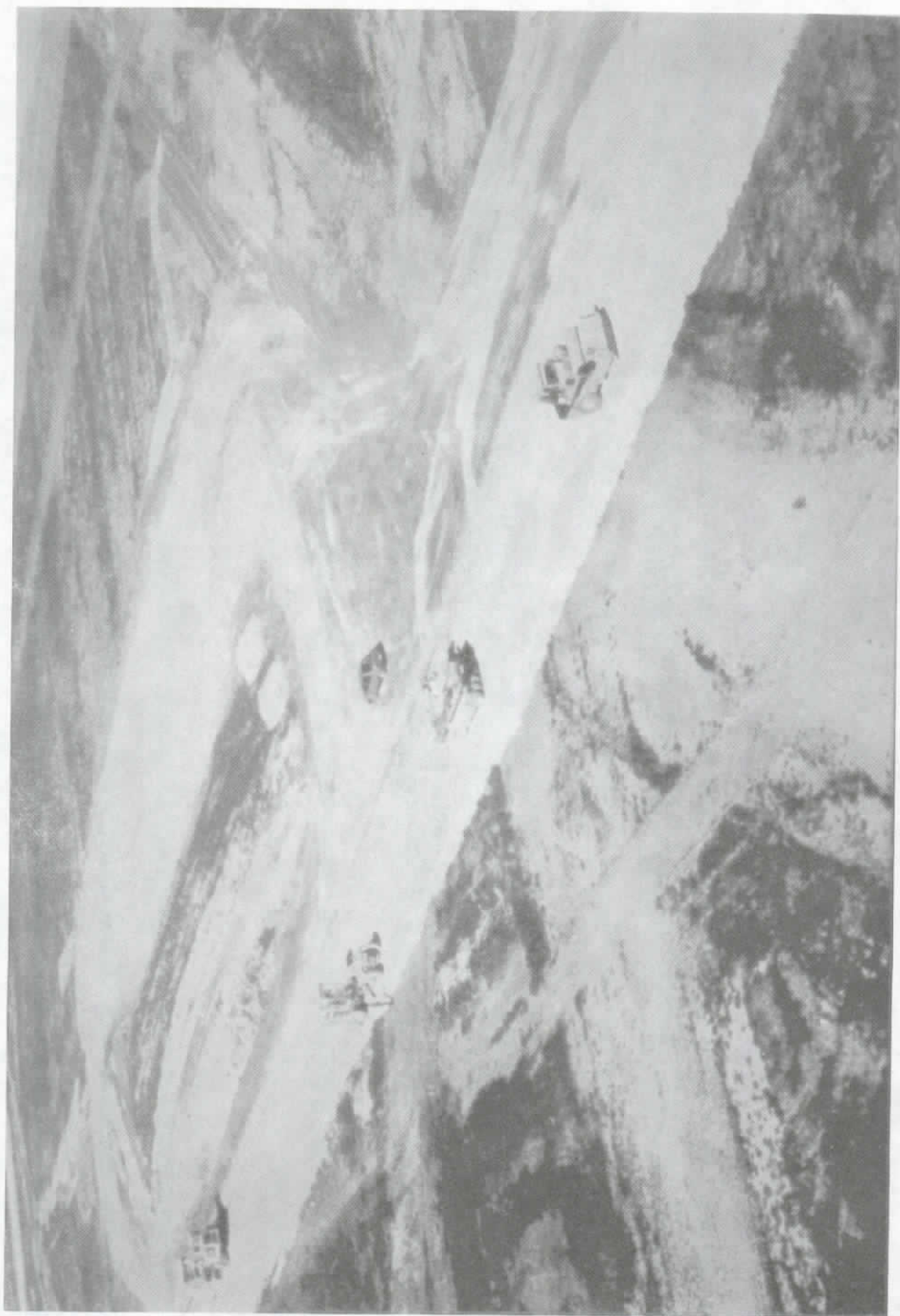
VUE D'ENSEMBLE DE L'ATELIER DE TERRASSEMENT DES PLATES FORMES AERONAUTIQUES
