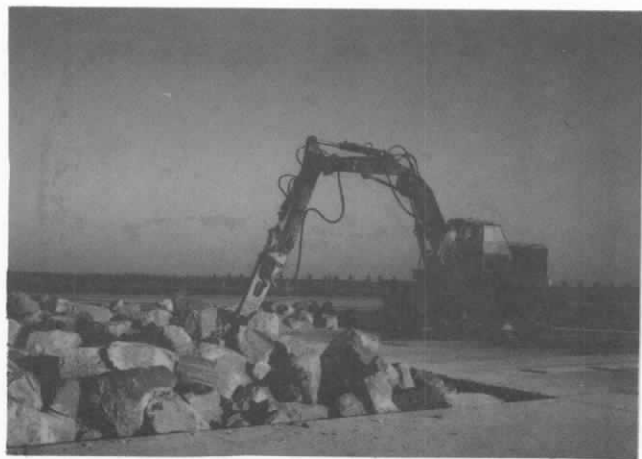
PHOTO 2 : Démolition du dalles cassées
