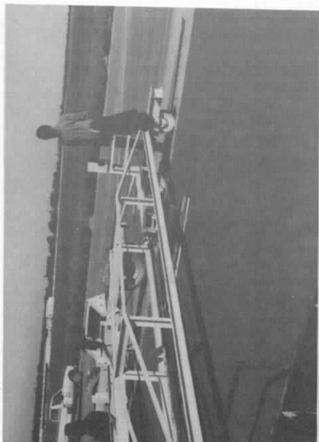
PHOTO 14 : Striage du béton frais pour balayage
