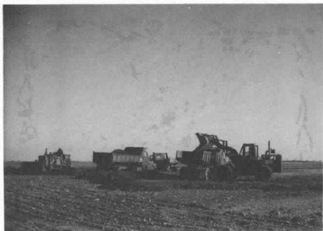
PHOTO 3 : Enlevement du TV 0/80 existant
