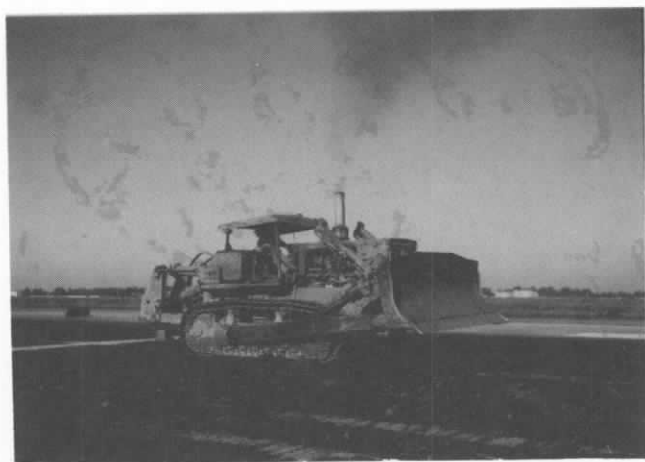
PHOTO 1 : Démolition du revêtement souple existant
