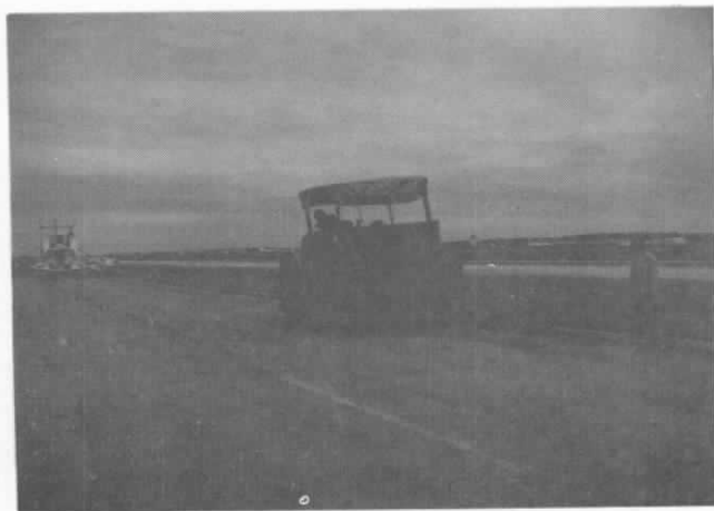
PHOTO 9 : Comactage de la grave ciment
