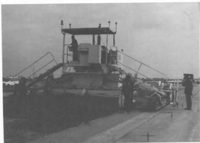
PHOTO 8 : Mise en place de la grave ciment à la machine Slip forme RAHCO
