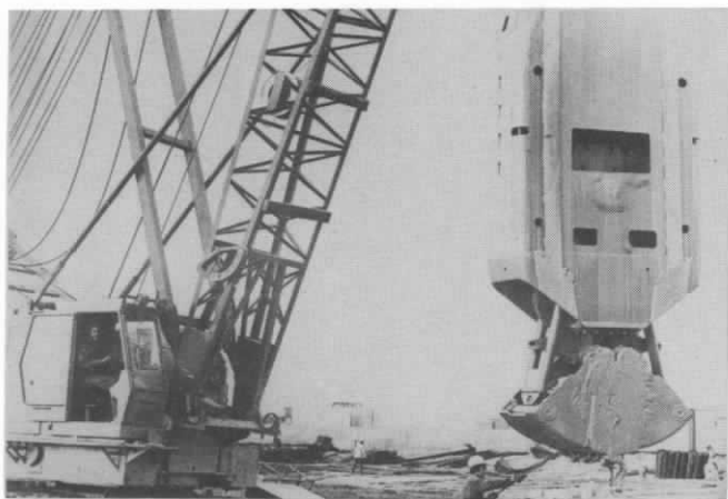
Benne K1 1200 : épaisseur 1,20 m, ouverture 2,70 m, poids 11 tonnes. (Document SIF BACHY)
