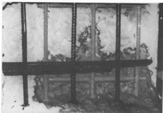
Procédé d'armature continues entre deux panneaux de paroi moulée. Le béton a été dégagé pour faire apparaître le recouvrement des deux nappes d'armatures adjacentes. (Document SIF BACHY)
