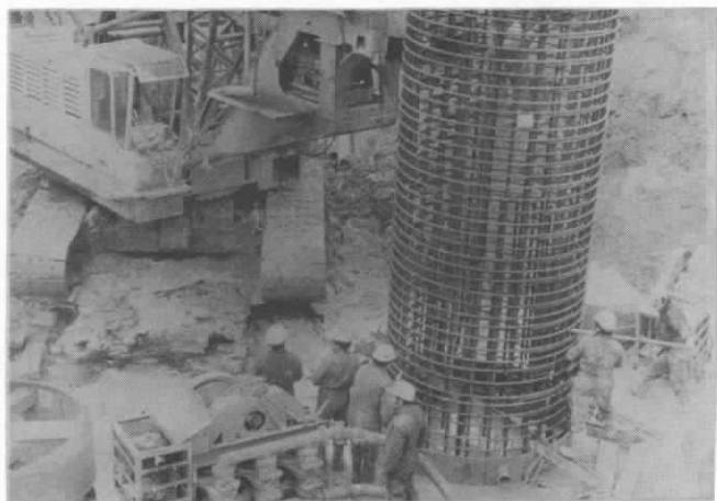
Mise en place de la cage d'armature dans un pieu de gros diamètre. (Document SIF BACHY)
