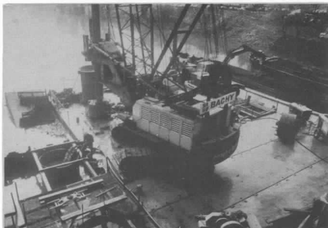
Forage de pieux Ø 2,50 m d'une pile de pont, en rivière. L'atelier de forage est monté sur un ponton flottant. (Document SIF BACHY)
