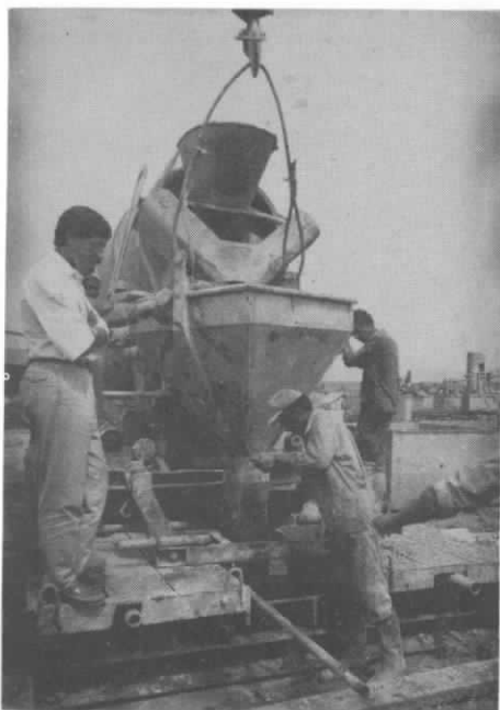
Bétonnage au tube plongeur d'une barrette. (Document Cie Marocaine SIF)
