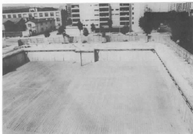
Paroi moulée préfabriquée présentant un fini parfait après creusement de la fouille. (Document SIF BACHY)
