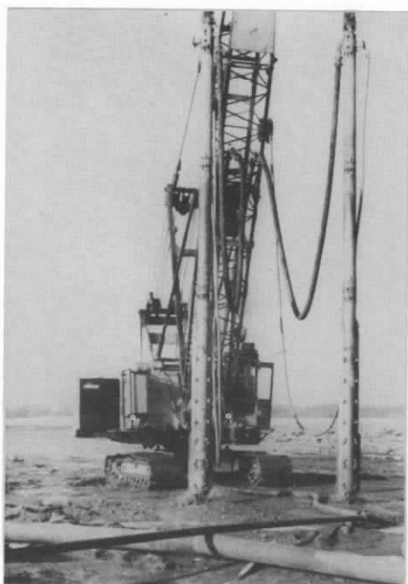
Appareil de vibroflottation. Ici, deux vibreurs lourds sont accouplés sur la même grue porteuse. (Document SIF BACHY)
