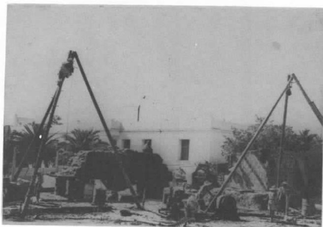
Forage de pieux au treuil de battage comme cela se pratiquait dans les années 50. (Archives SIF Tunis)
