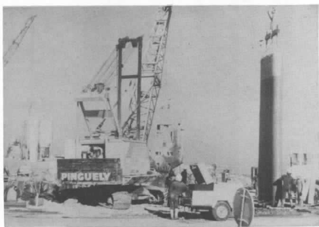
Barrette équipée d'un coffrage métallique sur une partie de sa hauteur au niveau de terrains caverneux. Le coffrage est descendu en même temps que la cage d'armatures. (Document SIF BACHY)
