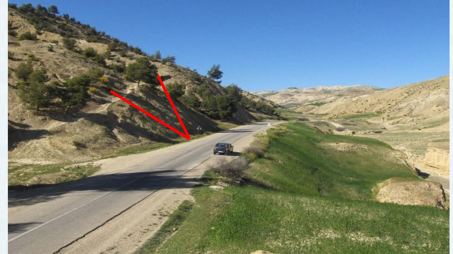
Voie express Taza Alhoceima. Passage d'une pente de 1H/3V à 1H/1V
