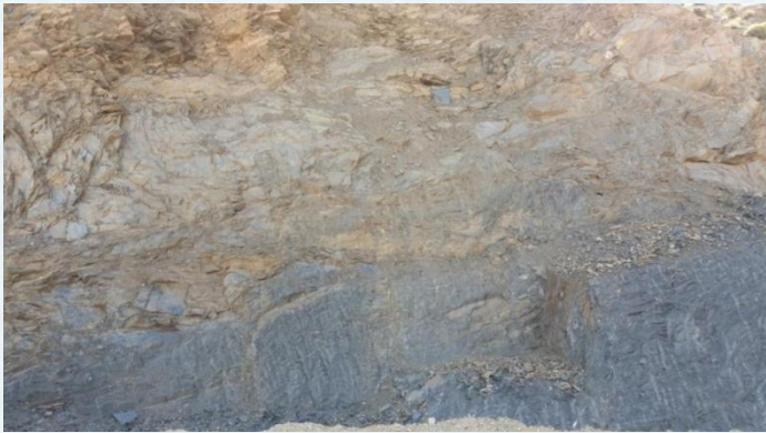
Formations du déblai: zone 3
