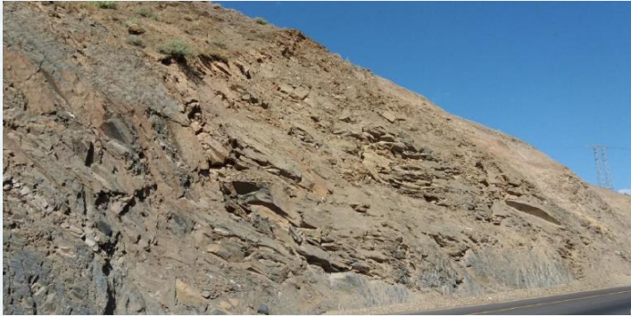
Formations du déblai: zone 1
