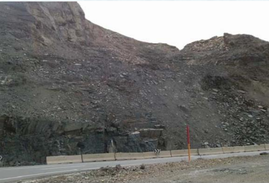
Talus amont de la PF sup – zone 5
