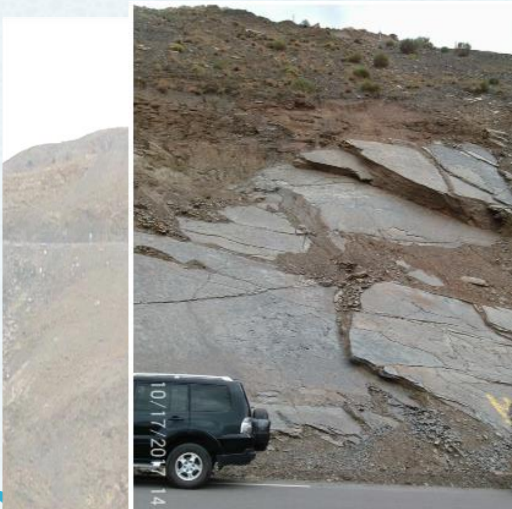
Formations du déblai – Talus amont de la PF inf – zone 3
