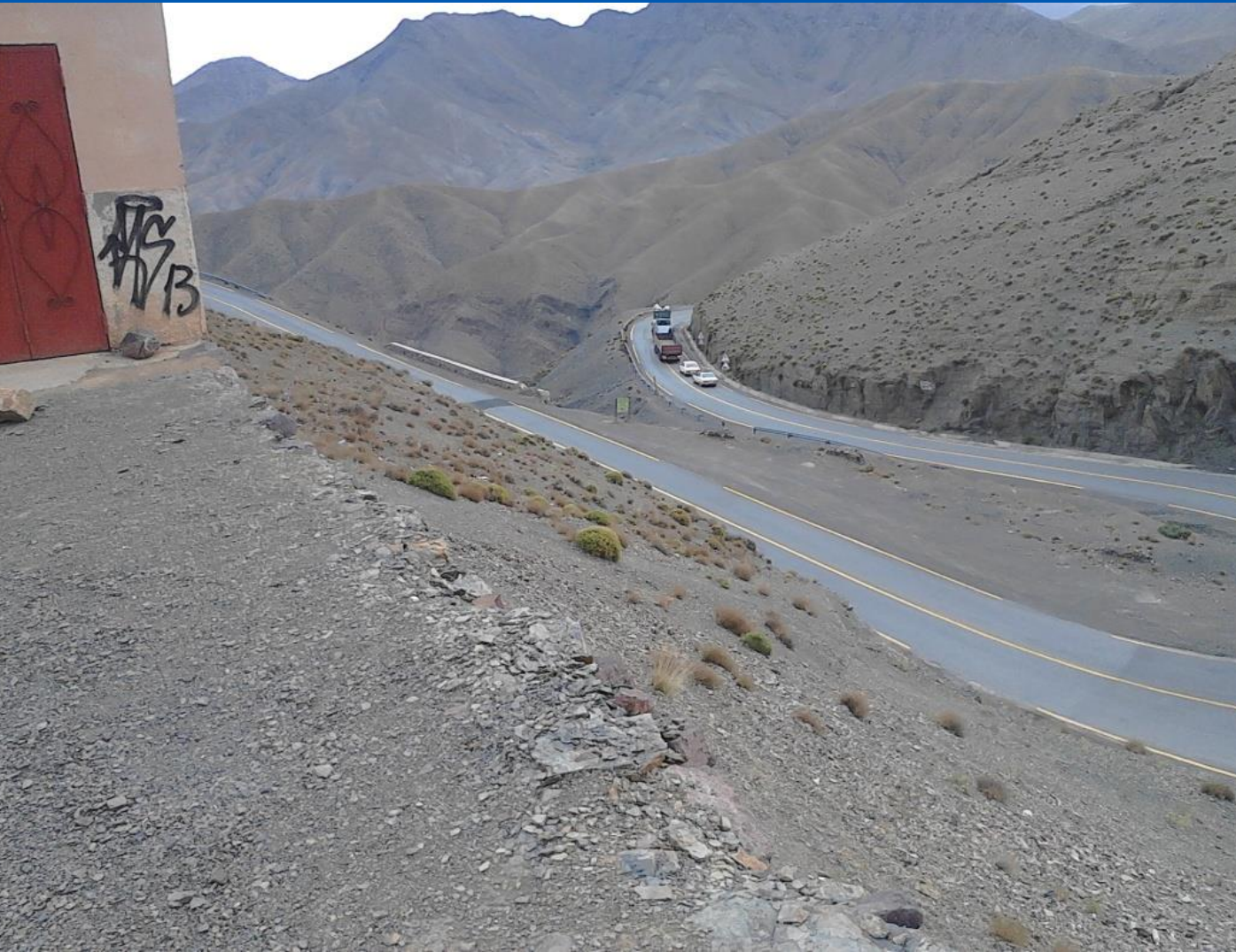
Aspect de la RN9 avant le projet d'élargissement
