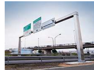
Portiques Potences et Hauts mâts
