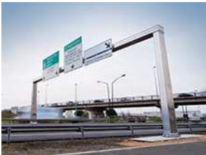
Portiques Potences et Hauts mâts
