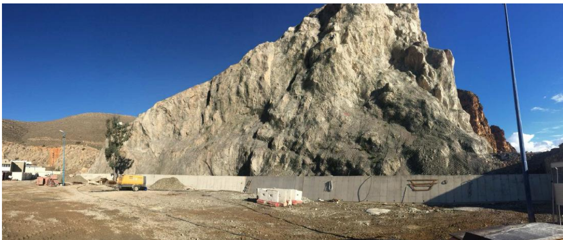
Fig. 3 – Vue de la falaise confortée par des filets HEA INOX, du grillage HR en PVC et barres d'ancrage
