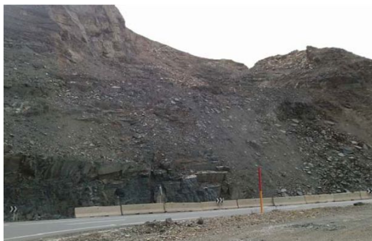
Figure 12: vues de la zone 5-6 : fissures dans le talus aval de la PF inf (à gauche) ; purge en crête du talus rocheux de la PF sup (à droite)
