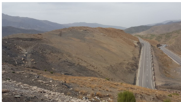
Figure 11: zone 4, PK 341.16/341-373 - fissures sur le talus amont de la PF sup
