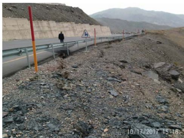
Figure 12: vues de la zone 5-6 : fissures dans le talus aval de la PF inf (à gauche) ; purge en crête du talus rocheux de la PF sup (à droite)
