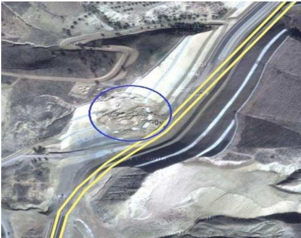
Vue d'ensemble du déblai D27
