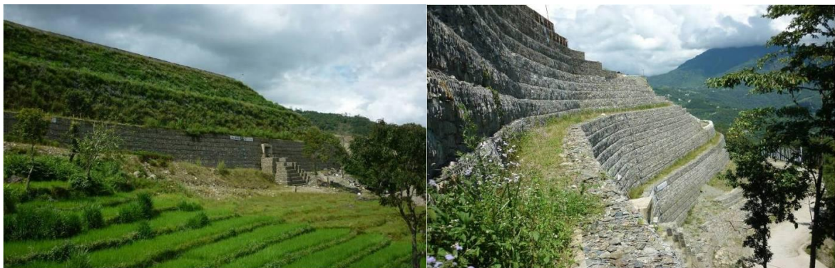
Figure 13. Photographies de l'ouvrage fini
