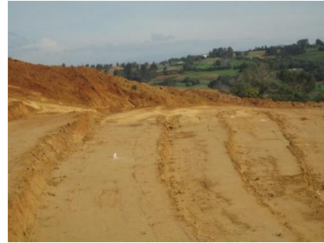
Figure 2: site du remblai 3119
